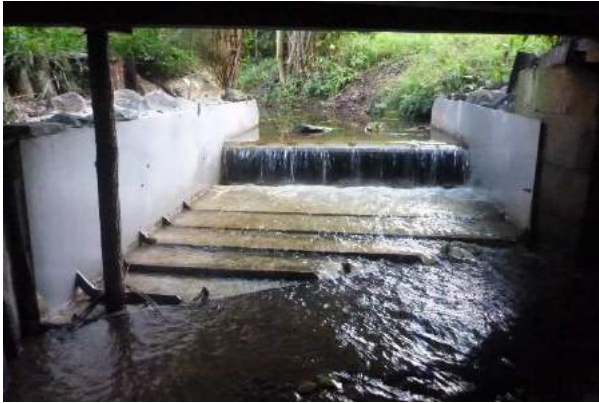
Abbildung 35: Untere Sperre einer generischen Doppelsperre (korrespondierend mit der Sperre in Abbildung 36). Verblechung und Überkragung eines neu gebauten Absturzes mit zusätzlicher Verblechung des gesamten Querschnitts. Zwischen den beiden Sperren befindet sich ein Monitoringbereich. Die Sperre dient dem Schutz des größten bekannten Bestands von A. astacus in Nordrhein-Westfalen. (Foto: H. Groß)
