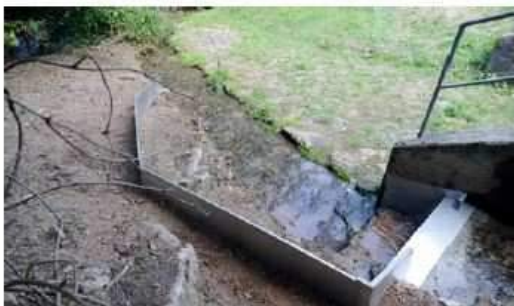
Ansicht in Fließrichtung.
