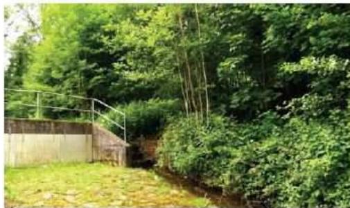
Anlage vor Beginn der Manahme.
