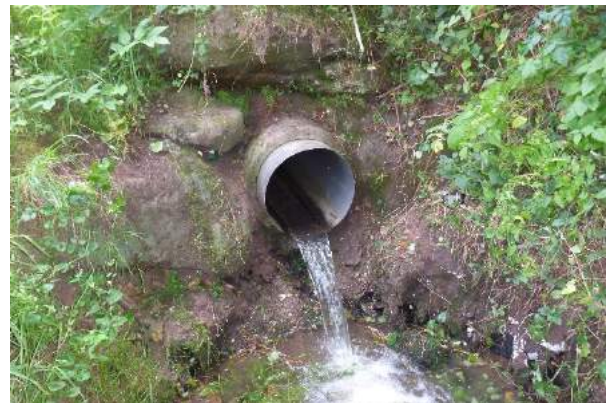
Abbildung 49: Die Verblechung von Rohrdurchlässen stellt eine der einfachsten und kostengünstigsten wie funktionalen Varianten für Krebs sperren dar. Hier wurde ein Blechrohr im Betonrohr installiert und dadurch ein Absturz erzeugt. Nach Entfernung der Vegetation (vgl. Abbildung links derselben Sperre) im Rahmen einer Unterhaltungsmaßnahme ist die Funktionalität wieder deutlich erhöht. Trotzdem besteht auf Grund der Uferausgestaltung die Möglichkeit, dass NICS diese Sperre über Land umgehen können, weshalb die Anbringung einer seitlichen physikalischen Sperre empfohlen wird (Pfeiffer, 2018a). (Foto: B. Schmieder)
