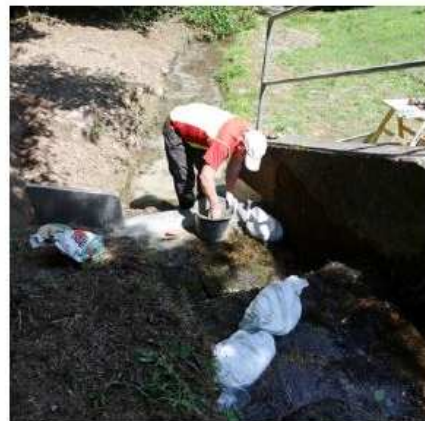
Baustelleneinrichtung mit wasserableitenden Sandsäcken.
