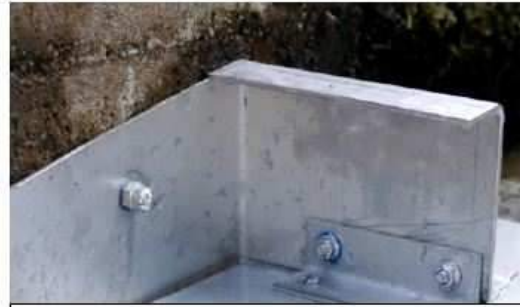
Befestigung an Betonmauer mit verklebten Hutmuttern.
