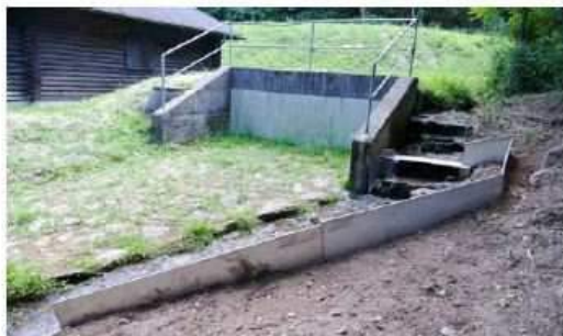
Gesamtansicht mit Hochwasserschutz einrichtung.
