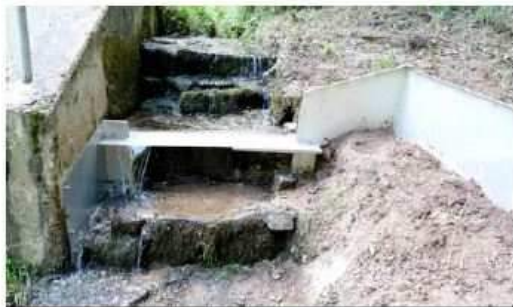
Ansicht gegen Fließrichtung.
