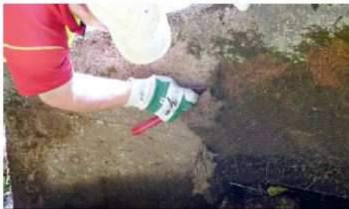
Betonwand von Moos befreien.
