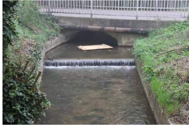
Abbildung 36: Obere Sperre einer generischen Doppelsperre. Verblechung und Überkragung eines neu gebauten Absturzes. Die vorhandenen Ufermauern dienen als Schutz vor Umwandlung. (Foto: H. Groß)
