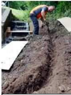
Verlauf des Graben.
