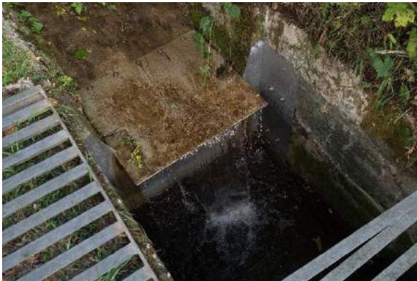
Abbildung 37: Der vorhandene Absturz in den Schacht wurde durch Verblechung modifiziert. Der Schacht ist mit einem Gitter abgedeckt. (Foto: Verfasser).
