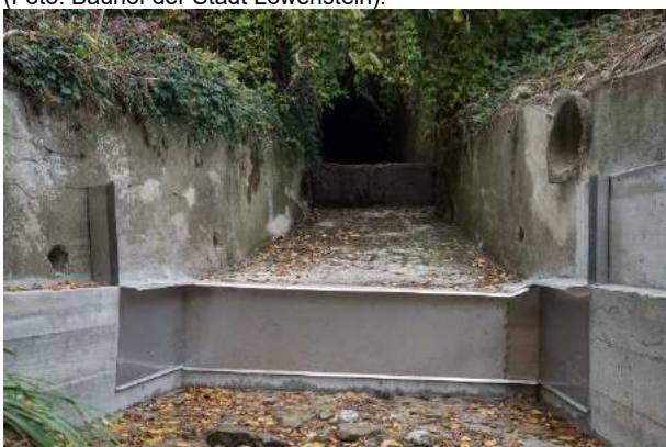
Abbildung 41: Blick vom Unterwasser auf die fertiggestellte Krebsperre. Deutlich zu erkennen sind die sanierten Teilbereiche die angebrachten Verblechungen aus Edelstahl. Die Anbringung der Verblechungen erfolgte durch einen Flaschner. (Foto: Verfasser)
