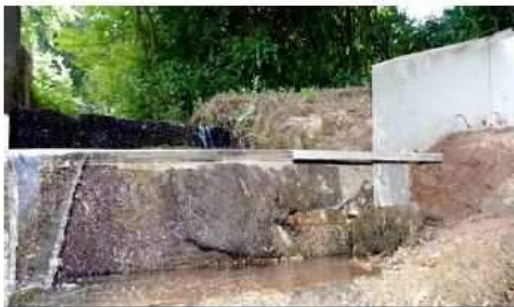
Ansicht gegen Fließrichtung.
