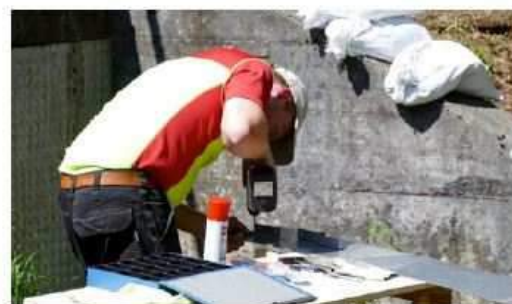
Bleche vorbohren und Bohrlöcher ansenken.
