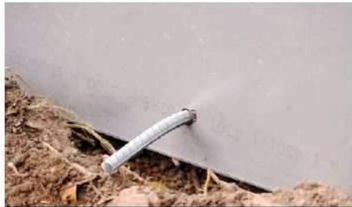
Moniereisen zur Diebstahlsicherung im Boden.
