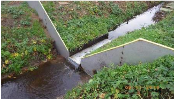
Abbildung 46: Einbau einer „Wand“ mit Absturz aus Blech ins Querprofil eines kleinen Fließgewässer. (Foto: W. Rötter)
