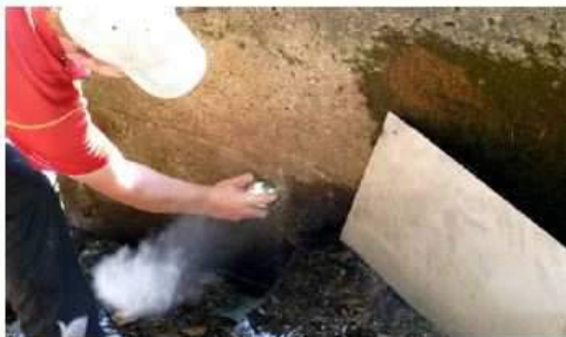
Bohrloch ausblasen mit Druckluft.
