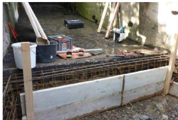
Abbildung 40: Detailansicht der Sanierung des Absturzes. (Foto: Bauhof der Stadt Löwenstein)
