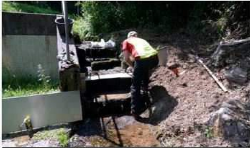
Mit wasserfestem Beton Öffnungen schließen.
