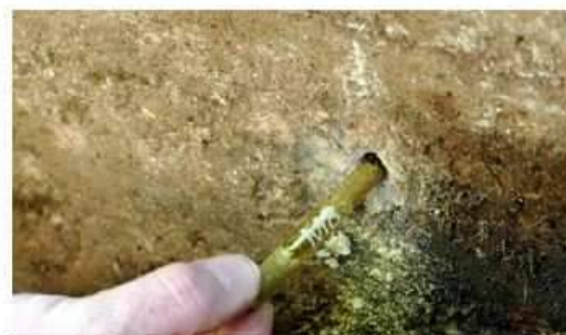
Klebedübel einbringen.
