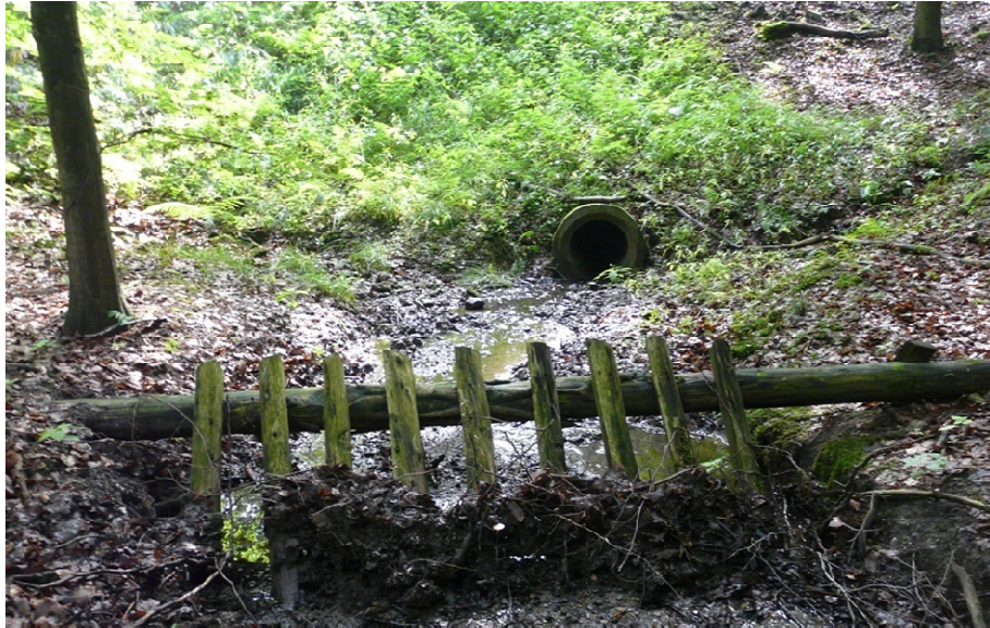
Abbildung 25: einfache Rechenkonstruktion aus Holz zum Zurückhalten von Geschwemmsel an einem namenlosen Nebengewässer des Heubachs (Quelle: BIOPLAN 2010)
