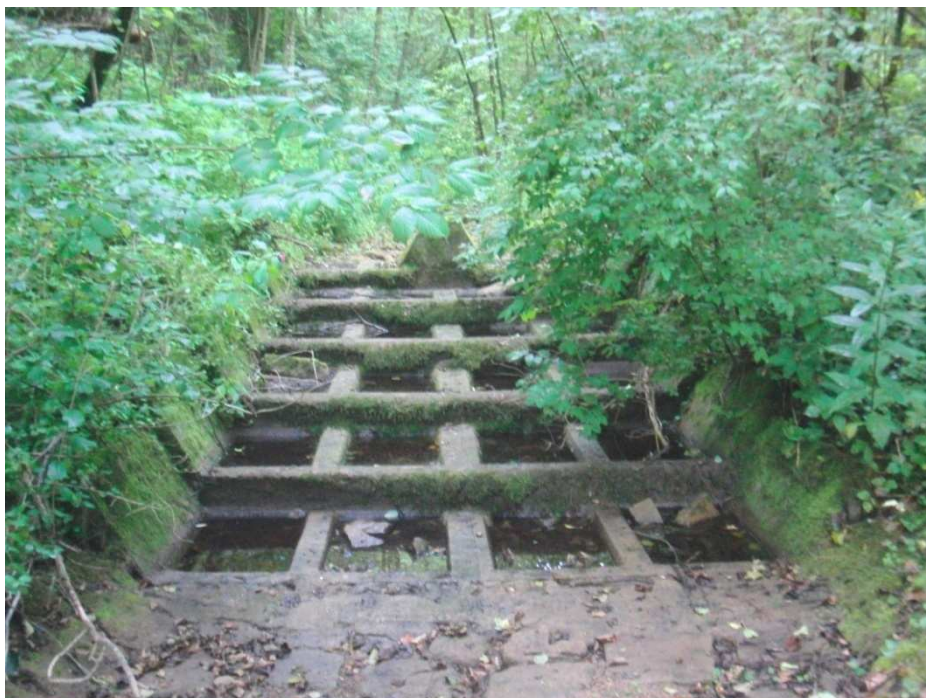
Abbildung 26: Q1: Fünfstufige Kaskade am Emdor Bach
