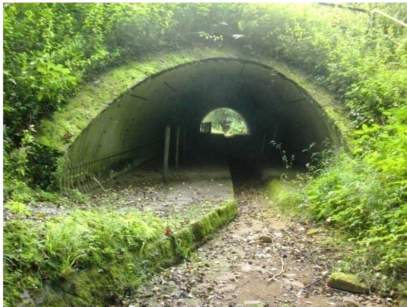
Abbildung 27: Q2: Unterführung des Emdersbachs unter der B252, Blick Richtung Mündung
