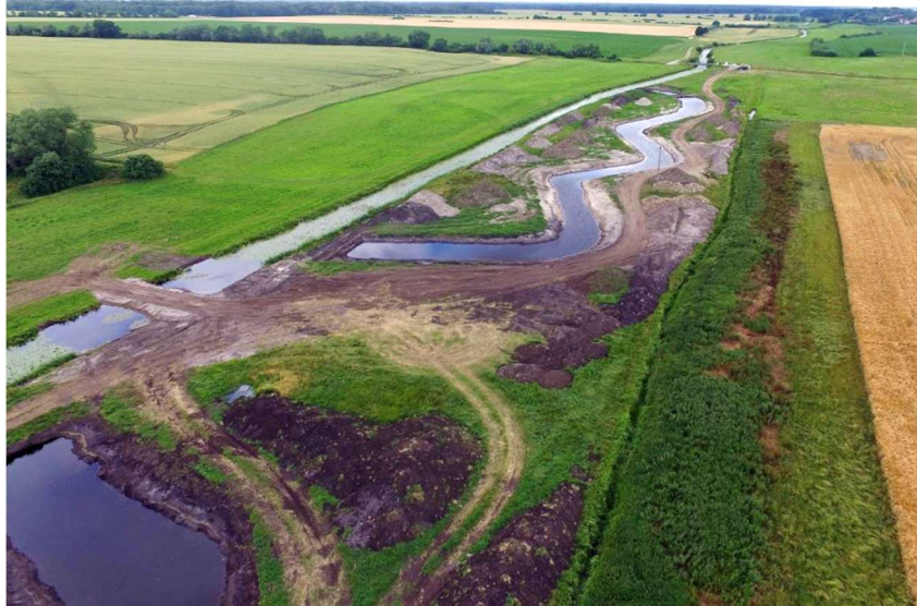
Abbildung 9. Vogelperspektive während der Renaturierung in Wobbelkow 2019. Barthe mit neu angelegten Teilabschnitten. Quelle: PfaU GmbH, 2019: Endbericht Ökologische Bauüberwachung: Bergung von Muscheln und Krebsen in der Unteren Barthe, 2.BA
