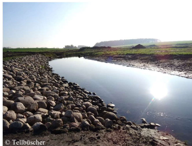
Abbildung 26. Renaturierter Abschnitt der Barthe mit Steinpackungen versehen. Aufgenommen am 14.11.2019 in Wobbelkow.
